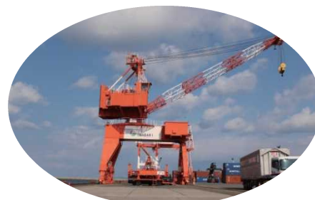
今治港ジブクレーン（愛媛県今治市）
