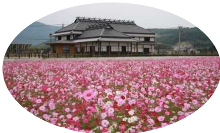
三光地区農業集落排水施設処理場（大分県中津市）
